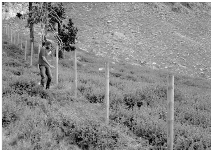
Installation d'une barrière de sécurisation d'une barre rocheuse dans les Hautes-Alpes.
