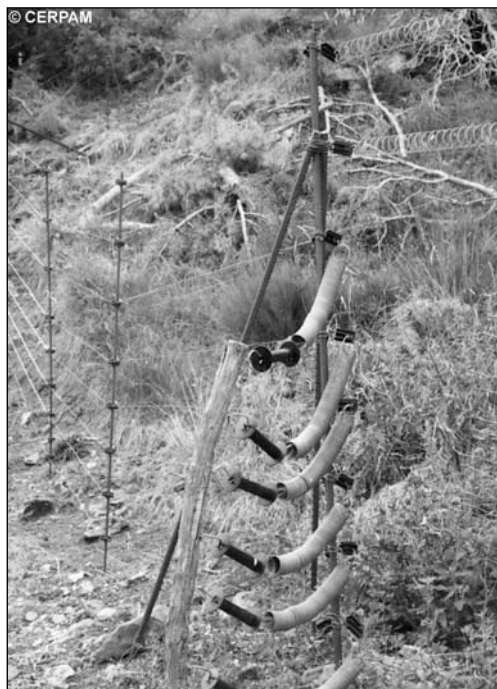
Dans les Monges, partie extérieure d'une double enceinte : 8 fils électrifiés de 1,80 m de haut.
